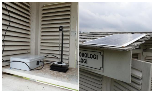
Gambar 19. Pemasangan alat pada taman alat
